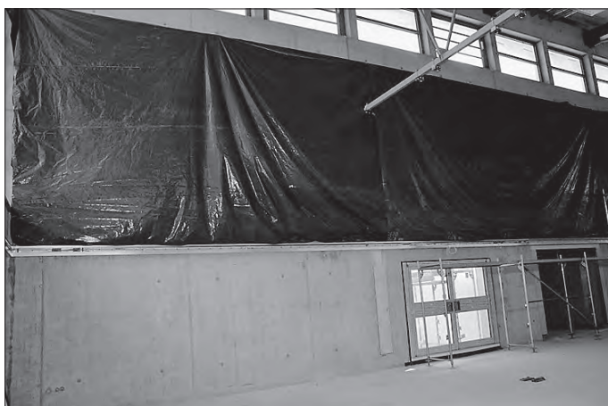
Eine Folie schützt die Absorber für die restliche Bauzeit
