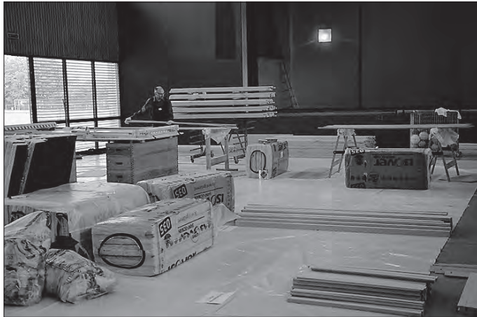
Einölen der sichtbaren Holzteile
