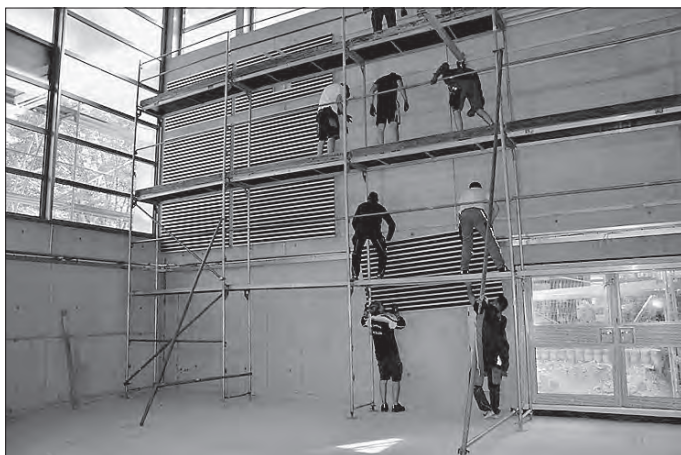
Einhängen der Schallabsorberelemente
